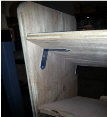
補強の金具と耐水考慮のゴム
