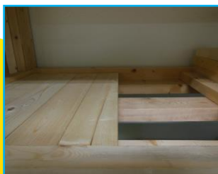
各棚は接合していないため 簡単に取り外し可能
