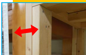
隣の大きな棚と接合 棚の倒壊を防ぐ
