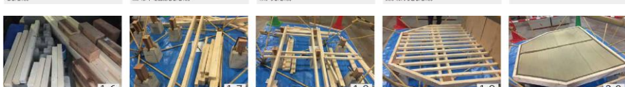
16 長さ: 上底 180mm 下底 220mm 高さ 250mm 面積: 900mm x 900mm 長さ 250mm 8本 2x2材: 13本 2x4材: 10本 ラワン合板: 5.5mm 2枚 17 菱形を積み重ねるようにならざるに左右を調整しようとしたが、どこにでも菱形が安定な形にならないので、菱形三十面体の外側に出てしまったりと納まりが利かなくなりました。 18 一部菱形のパーツを外し床を作ることにしました。菱形三十面体の構造美であるはずでしたが、菱形三十面体の外側に出てしまったりと納まりが利かなくなりました。 19 なるべく 2x4材の面で床を固定し、その上に 2x2材をクロスさせるように設置した。2x4材と床をビスで5ヶ所固定した。 20 こまめな大きさに切り、切り口が鋭くないようにビニールテープを貼りました。その上にこの構造(ぶち)に近い色のテープを張り付け床を完成させました。
