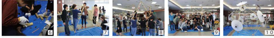
6 継ぎを割れないようにするが、内径に合わせた継ぎの穴の位置を合わせるための角度が継ぎに対して角度でないと少しが隙間が生じた原因になります。 7 継ぎをしっかりと固定することを確認し取り付けました。一人一人がやるべき作業を交代していったおかげで、五角形が完成しました。 8 二つの五角形を同時に設置し継ぎを竹で組み立てました。上の五角形に乗りて支えるのも一苦労だったので、互いにあったコーナーで継ぎを交えました。 9 最後は先生や学生が来て手伝ってもらって完成しました。これのおかげで継ぎを交えず簡単に完成させることが出来ました。 10 正二十面体の状態で形を整えました。この状態で菱形三十面体にするのができ、綺麗な形になりました。
