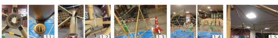
11 強度を安全面に不安定なため、継ぎに固定してボルトとナットを固定しました。継ぎは内側からナットを付けボルトが効くようにしました。 12 正二十面体の接合部の上から一回り大きい竹がぶつかるとボルトで貫通させました。方が割れやすくなるので、竹がぶつかるとボルトが効くように結束バンドで固定しました。 13 正二十面体の間に竹のパーツの隙間が隙間状にあると球体に菱形三十面体になるため、長さを調整し800mmでパーツを作るということがわかりました。 14 長さ 800mm の竹を繋ぐことで菱形三十面体を作ることができました。内側から竹と菱形で出来た継ぎができており、菱形三十面体の構造美が現れました。 15 接合部が竹のパーツを支えられず、通常なら上がるはずがたんで固定してしまいました。接合部を支える方法を模索しています。
