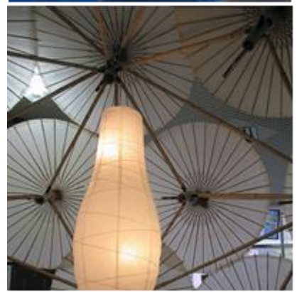
1 竹: 直径 20mm ~ 30mm 長さ 1,500mm 20本 竹: 直径 20mm ~ 30mm 長さ 800mm 60本 竹: 直径 500mm ~ 590mm 長さ 180mm 32本 継ぎ: 280個 糸: 3x15 380本 2 継ぎを接合部の先端に付け、傘を入れるための溝をつけようとして組み立てている。直径 20mm ~ 30mm で長さ 1,500mm の竹は入りやすく継ぎをする心配もないためビスで固定しました。 3 三角形の頂一つだと割れる心配もなかったが、正五角形に組み立てると力がかかるはず継ぎが割れてしまいました。継ぎの先端に鉛筆の芯で割れにくい材料の改善が必要とわかりました。 4 接合部の継ぎを先で補っていたために断面が歪み割れしやすくなるので途中で継ぎをこのように割りました。継ぎ、組み立て時に割れず、このように割れはしませんでした。 5 接合部の切断面に 72度ずつ印をつけ、割線の上下に 100mm の幅まで位置を合わせました。位置を合わせると組み立てる時にずれが生じ、竹に継ぎが力がかかり割れる原因となります。
